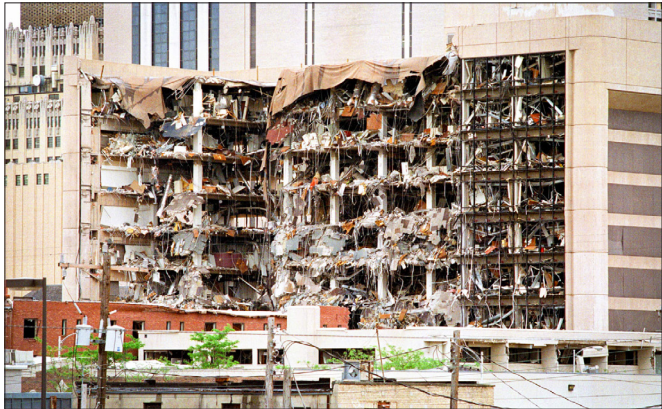
ساختمان فدرال پس از انفجار
