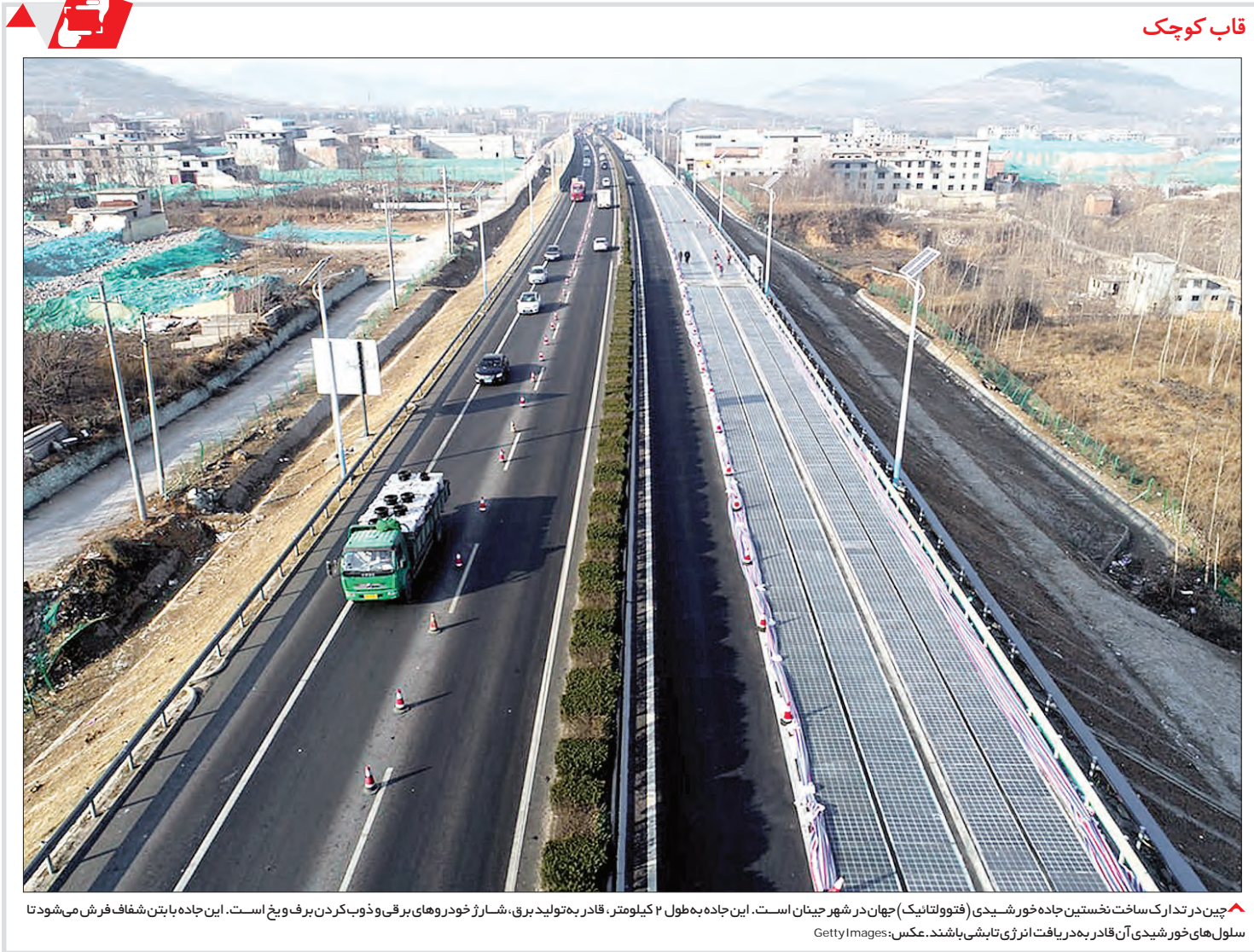
پیرن در تداک ساخت نخستین جاده خورشیدی (فتوولتائیک) جهان در شهر جینان است. این جاده به طول ۲ کیلومتر، قادر به تولید برق، شارژ خودروهای برقی و ذوب کردن برف و یخ است. این جاده با بتن شفاف فرش می شود تا سلول های خورشیدی آن قادر به دریافت انرژی تابشی باشند. عکس: Getty Images
