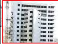
فصلی سقوط بالابرو ساختمانی
