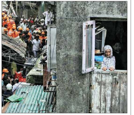
مومبای، هند - پیژنی که در حال تماشای کارگرانی است که بیرون از خانه‌اش مشغول امداد رسانی به حادثه‌دیدگان سقوط ساختمان هستند.
