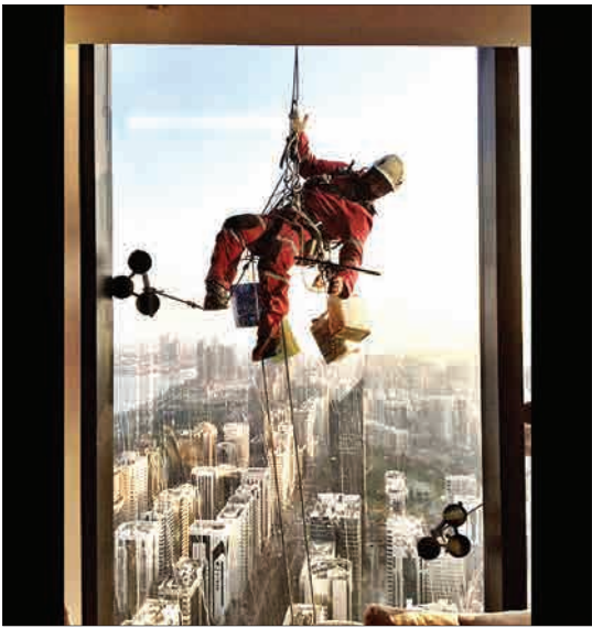
شستن پنجره‌های یک برج در ابوظبی در طبقه ۹۰.
