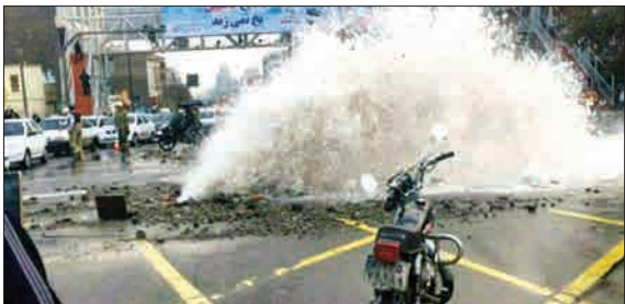
ترکیدگی لوله آب در میدان توحید باعث ایجاد ترافیک سنگین شد. (تهران آنلاین)
