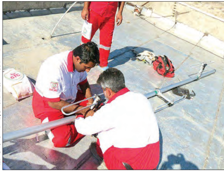
تجهیز و راه اندازی سیستم آتش‌نشانی یادمان شهدای سپهریک
