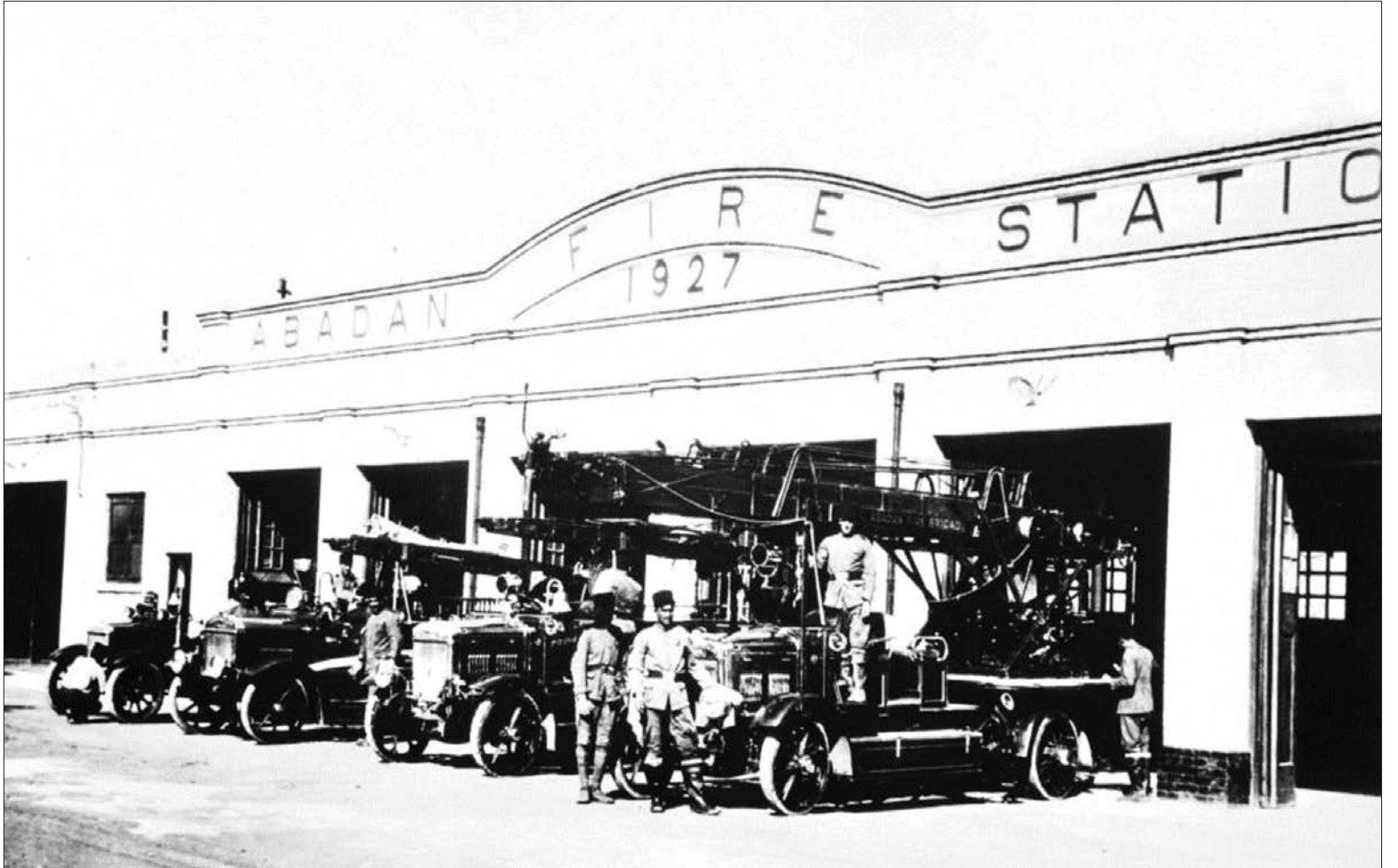
ایستگاه آتش‌نشانی آبادان
